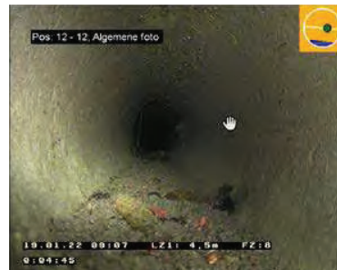
Abb. 7: Beispiel für eine typische Sedimentschicht von unter 2 cm
