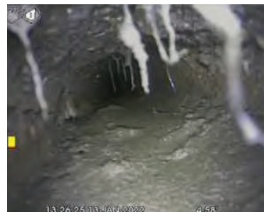
Abb. 8: Beispiel für eine Sedimentschicht von über 2 cm
